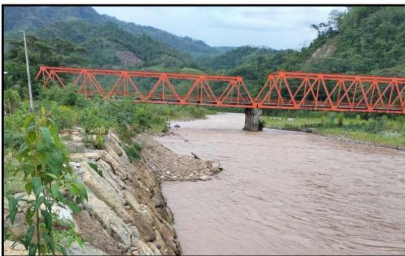
FIGURA N°04: EN LA TEMPORADA DE MAXIMAS AVENIDAS, EL RIO PAUCARTAMBO INCREMENTA SU CAUDAL OCASIONANDO DAÑOS A LAS ESTRUCTURAS DE DEFENSAS RIBEREÑAS EN LA MARGEN DERECHA DEL RIO.
