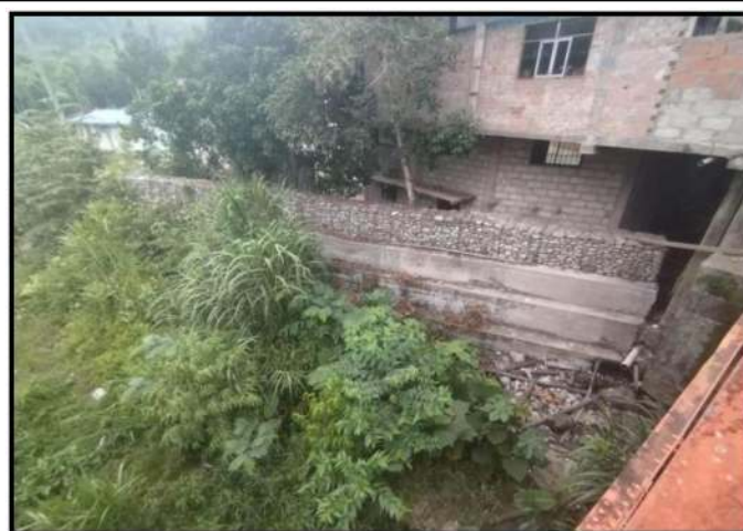
FIGURA N°02: DAÑOS POR INCREMENTO DEL CAUDAL DEL RÍO PAUCARTAMBO Y PELIGROS A LAS VIVIENDAS Y EROSION A LOS CIMENTOS DEL PUENTE CAPELO
